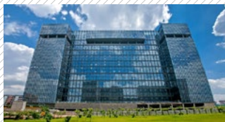
腾讯光明中国移动 / 万国数据 数据中心二期 运行类 AAAAA
