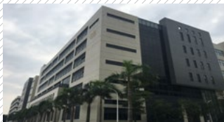
万国数据广州一号数据中心 运行类 AAAA
