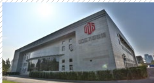
万国数据北京一号数据中心 运行类 AAAA
