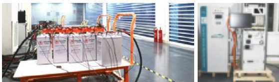
多能源输入智慧能源测试平台
