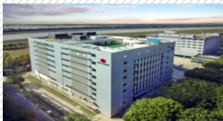
万国数据深圳一号数据中心 运行类 AAAA
