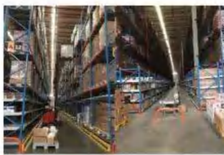
入库作业区 Miniload箱式堆垛系统
